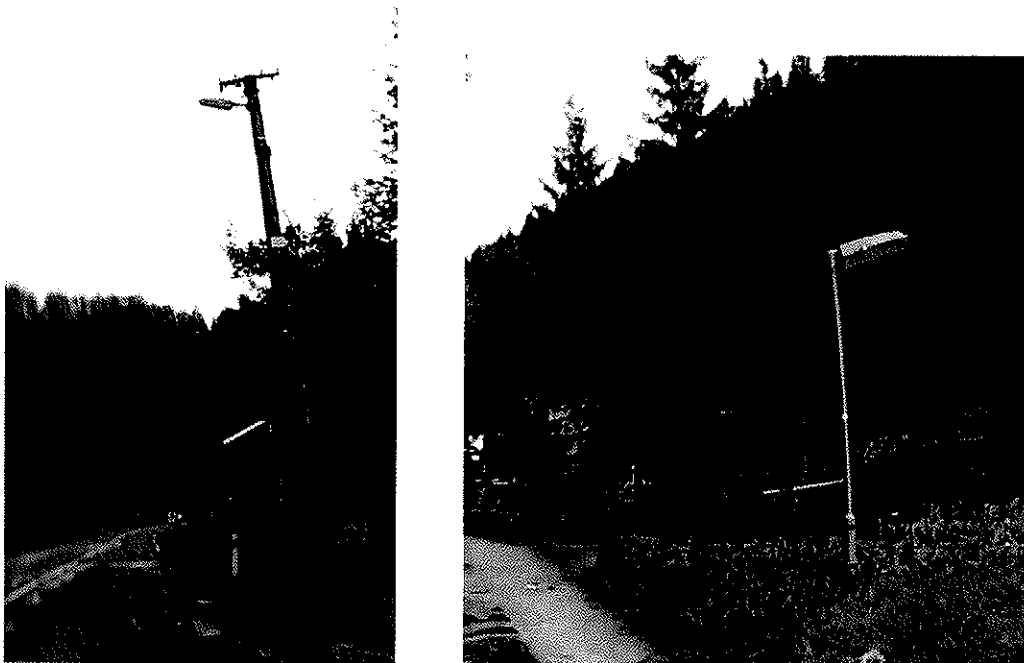
Obr. 3 Svietidlo VO na betónovom a oceľovom stožiaru
